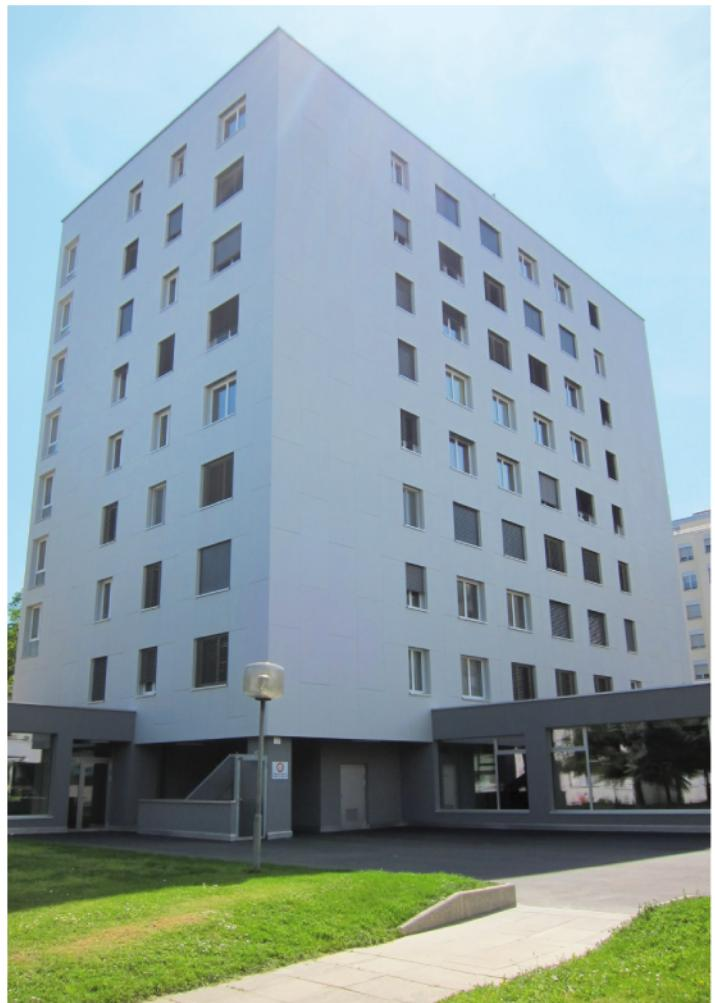
embrasures et de rendre ainsi le bâtiment élégant et élancé. Le PVC a remplacé le bois sur toutes les nouvelles fenêtres, et des tablettes ont été créées à l'intérieur des appartements dans le but de définir une ligne encore plus pure en façade.
